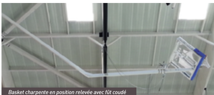
Basket charpente en position relevée avec fût coudé
