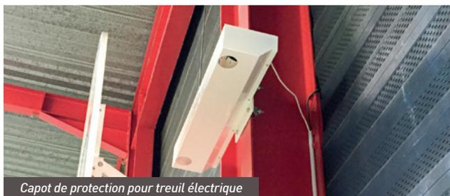
Capot de protection pour treuil électrique
