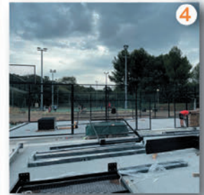
4 Installation de l'armature métallique
