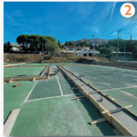
2 Fabrication de la dalle en béton poreux
