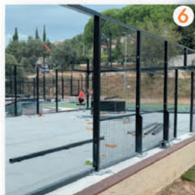
6 Mise en place des grilles
